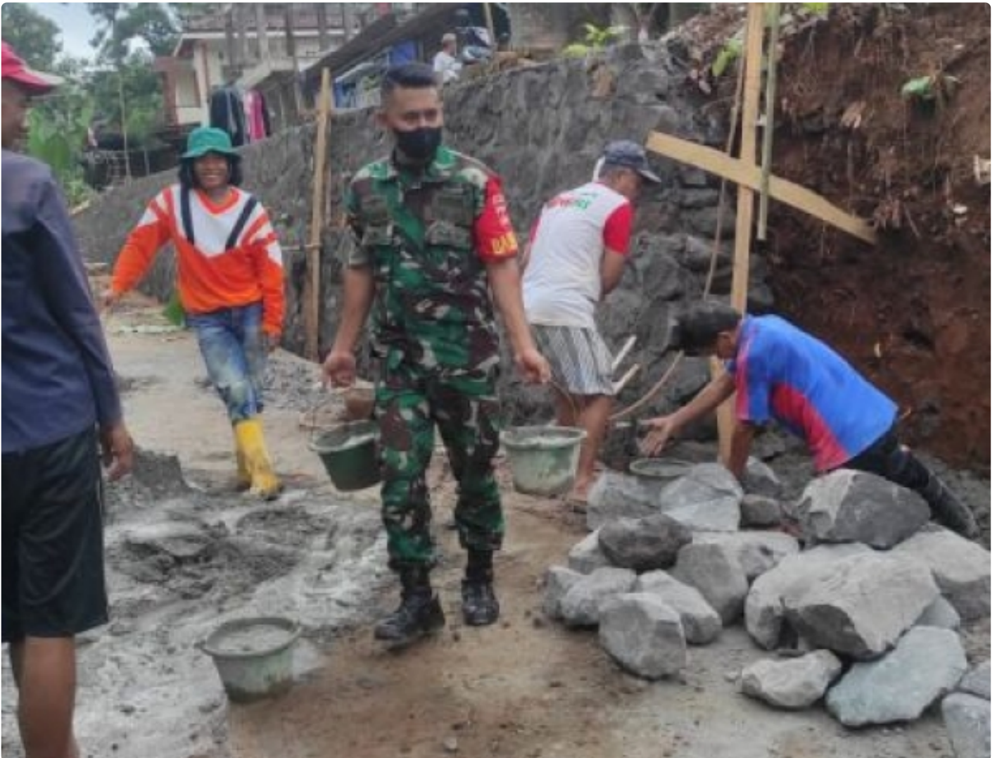
Membawa ember berisikan adukan semen, Serda Nasikin terjun langsung dalam pembuatan talud di Dusun Klowoh, Desa Lemahireng, Kecamatan Bawen.
